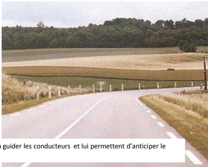
Entre ces deux exemples, celui de gauche montre que les arbres suffisent à guider les conducteurs et lui permettent d'anticiper le virage. A droite on est obligé de marquer le virage par des potelets.
